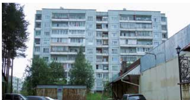
Förfabricserade betongelement efter sovjetiska standardritningar. Ingen hänsyn togs till lokal tradition eller miljö, varken här eller annorstädes.
