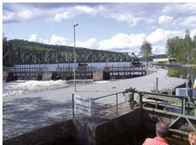
Även järnvägen spred tekniska innovationer långt upp i de Dalsländska sjösystemen. Här är järnvägens svängbro ovanför Dals Långed. I förgrunden kanalen med sin slussport.
