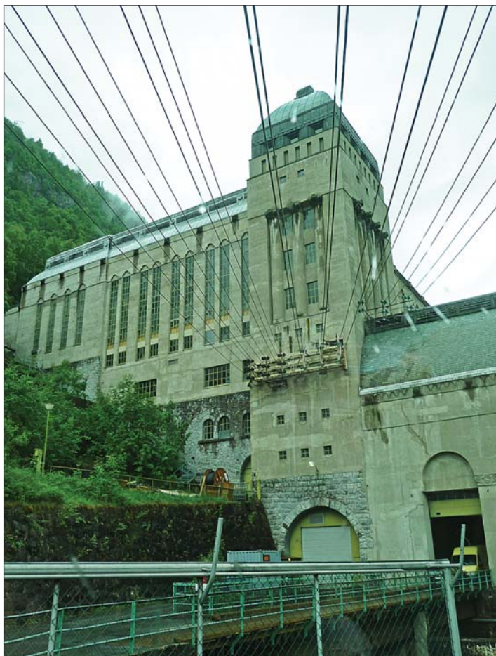
Kraftstasjon på Rjukan. Foto Bjørn Petersen
