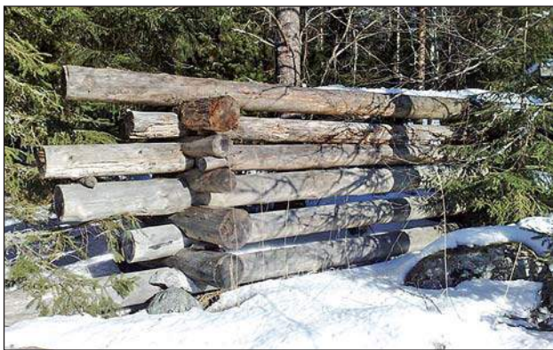
Bastanta staket gjordes runt om gårdarna när man gjorde innergårdar vargsäkra. Reino Halin, Lammi, Tavastlands, Finland. Vargen kan hoppa men föredrar att smyga längs linjeobjekt (tills den hittar en öppning att krypa igenom).
