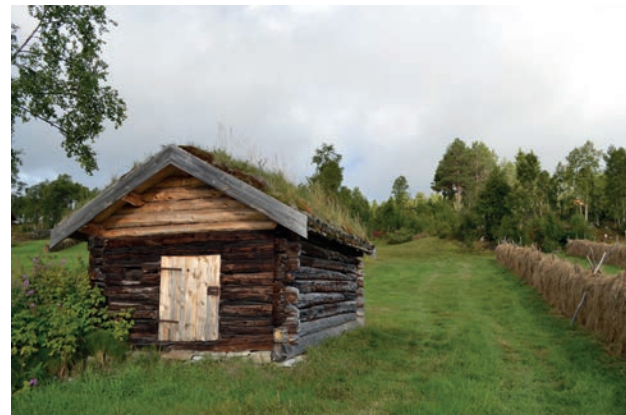
Tømmerløe på Ålbygghagaen ved Hittersjøen på Røros. Istandsatt av Uthusprosjektet i 2005. Foto: Randi Borgos, 2020
