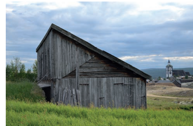
Ombygd løe med pulttak på Rammhagaen på Røros. Opprinnelig var dette en løe med saltak. Løa er fortsatt i bruk som høyløe. Foto: Randi Borgos, 2020
